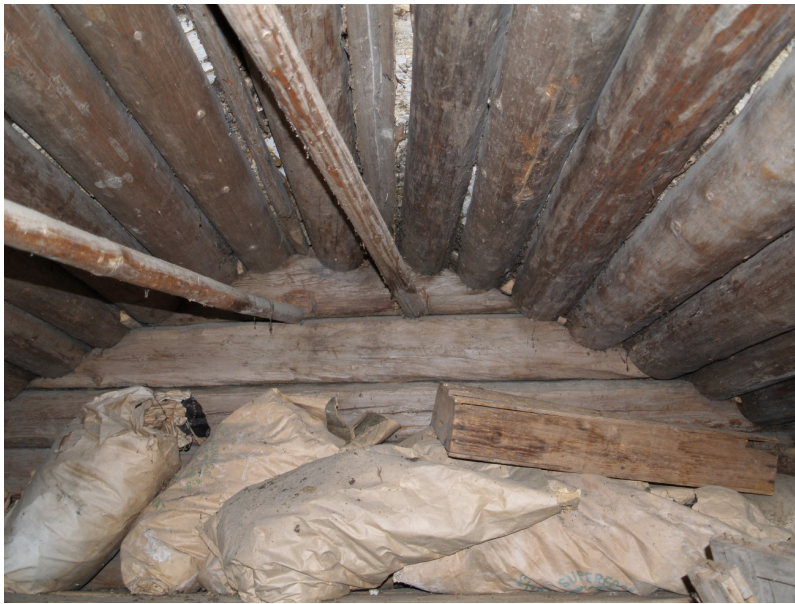
Takkonstruktion från insidan
