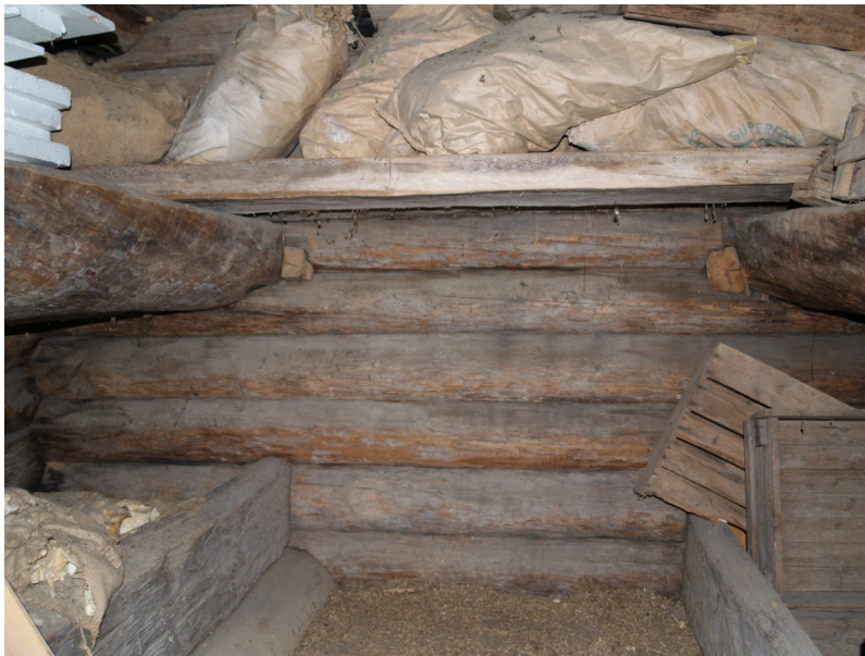
Insidan med hyllkonstruktion och avbalkningar
