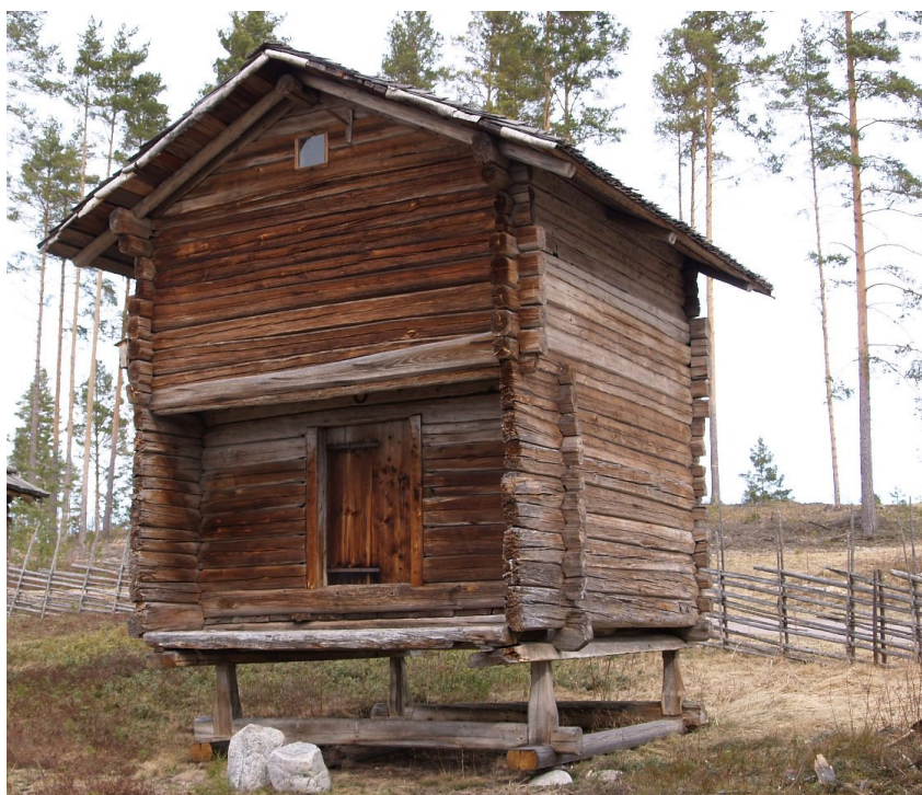
Minnesstugan GMS05, stolphärbre i 2 våningar Provens placering i byggnaden
